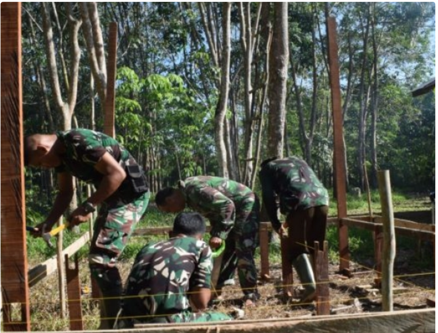
Satgas TMMD Ke-113 Kodim 1005/Barito Kuala Kebut Pembangunan Pos Kamling
