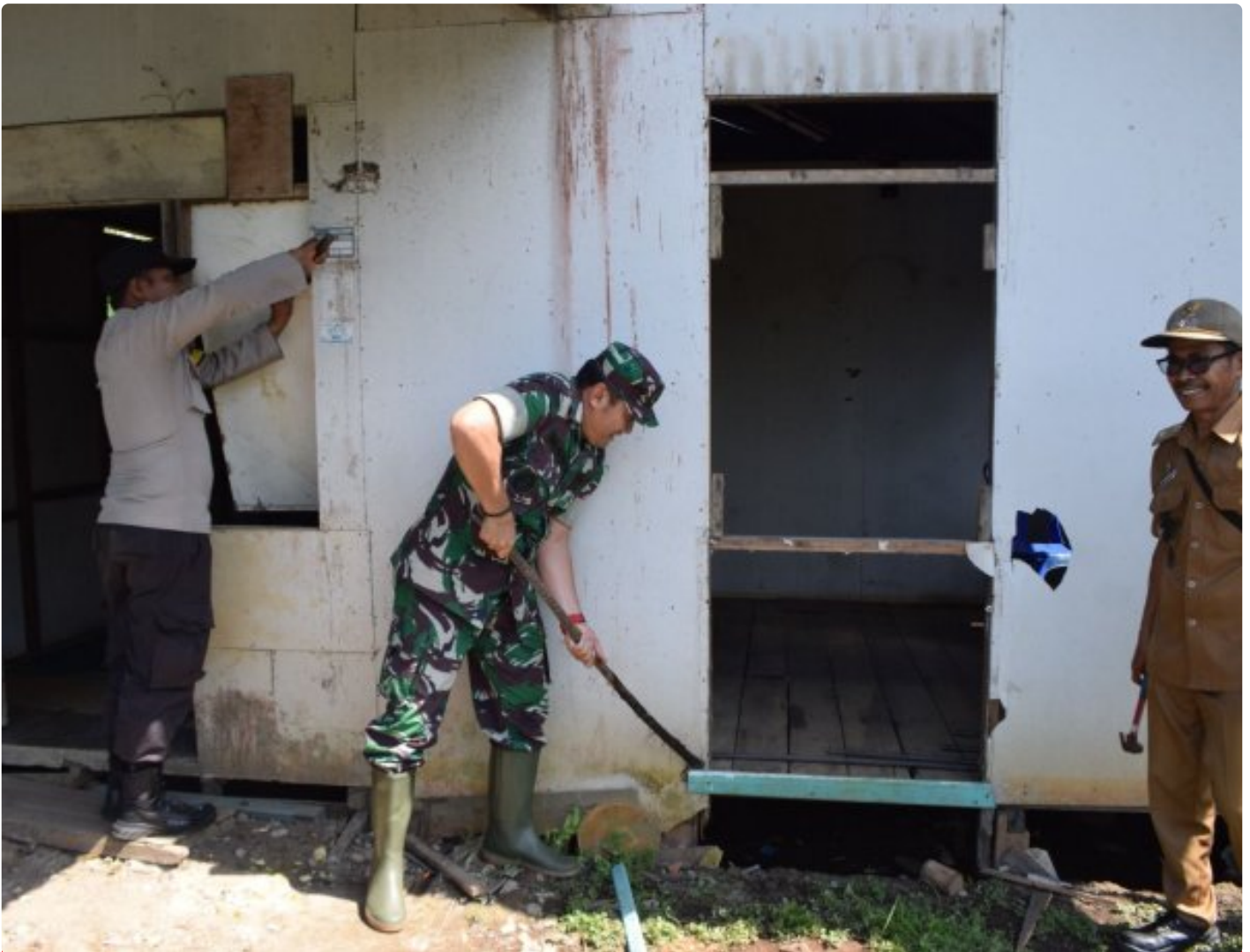
Pembongkaran Awal Rumah Tidak Layak Huni (RTLH) Mulai Dikerjakan Oleh Kodim 1005/Barito Kuala
