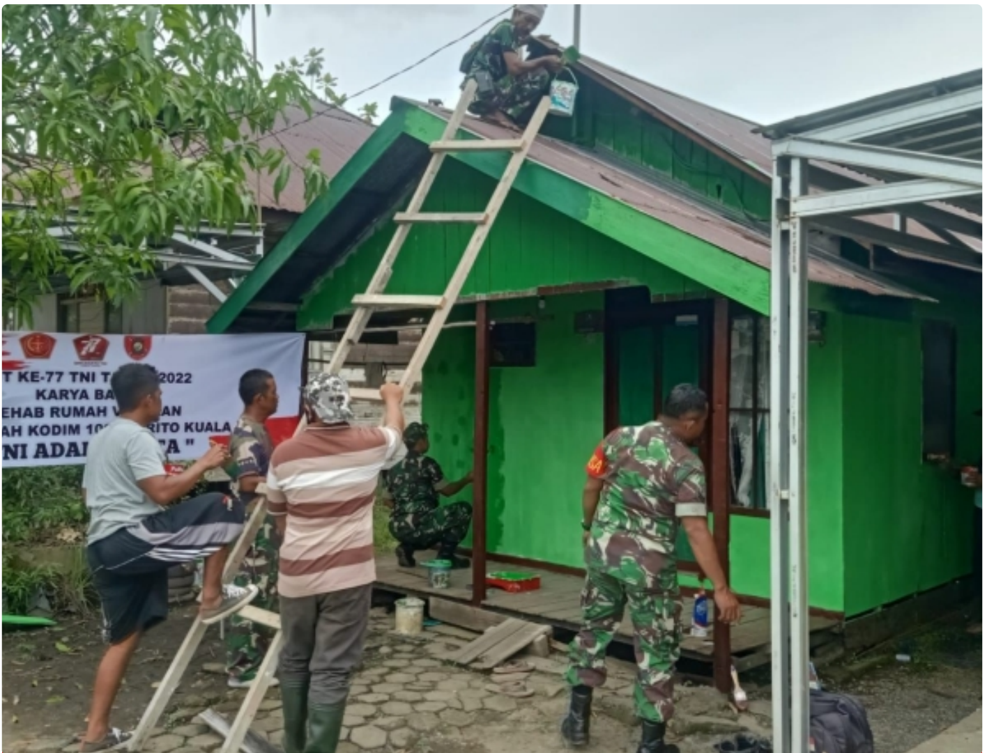
Anggota Kodim 1005/Barito Kuala Rehab Rumah Veteran
