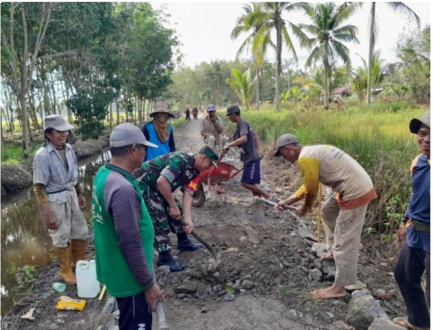
Bersama warga Binaan Babinsa Koramil 1005-10/Tamban Perbaikan Jalan Menuju Perkebunan
