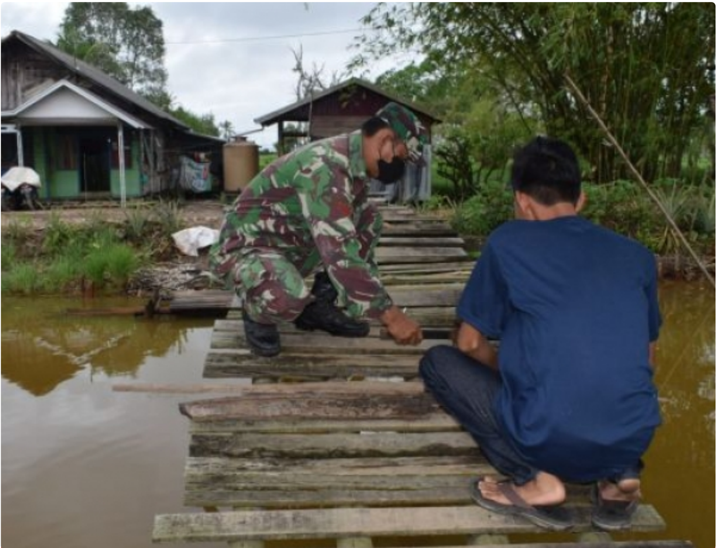
Babinsa Kodim 1005/Barito Kuala Bantu Perbaikan Jembatan
